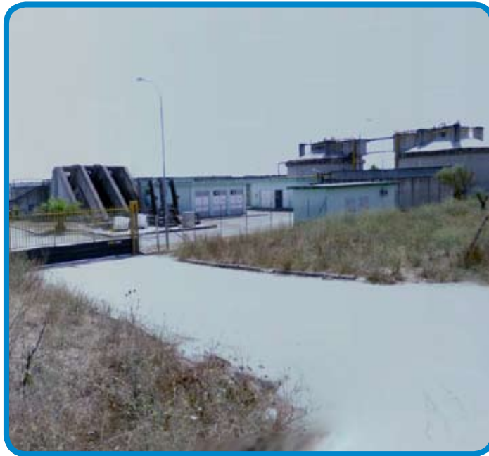
Il depuratore di via del Campo
