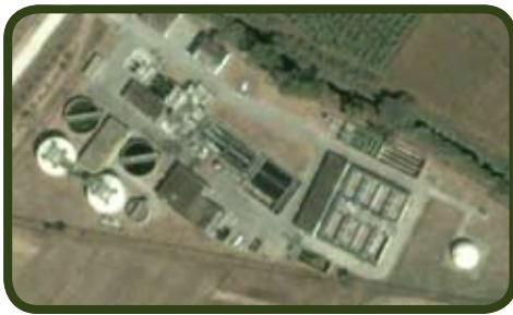
Il depuratore di via del Campo
